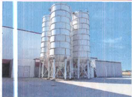
Zona silos exteriores de materia prima
